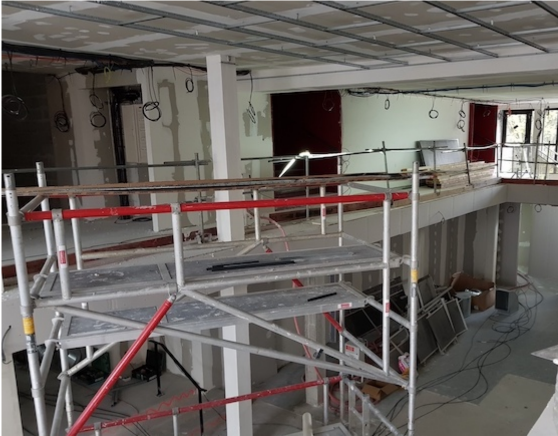
Le hall, en haut avec les deux entrées vers la salle de spectacles
